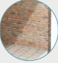
**Verifica del supporto** Prima di procedere è necessario verificare che il supporto sia planare e senza distacchi, privo di efflorescenze o di umidità di risalita. Sarebbe preferibile rimuovere eventuali rivestimenti o pitture non traspiranti.
