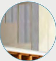
**Realizzazione di una controparete** costituita da struttura autoportante; posa delle lastre di cartongesso, eventualmente raddoppiate se richiesta maggiore robustezza. La controparete interna consente di posizionare agevolmente l'impiantistica lasciando inalterato il pannello isolante ed evita il ponte termico causato dai profili metallici.
