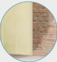
**Applicazione** del pannello isolante con i giunti ben accostati, fino ad avere il rivestimento accurato di tutta la parete. Il fissaggio potrà essere realizzato a colla o meccanicamente con tassellatura direttamente alla parete.
